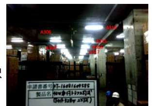
【設置後の状況(工事完了報告書からの抜粋)】
